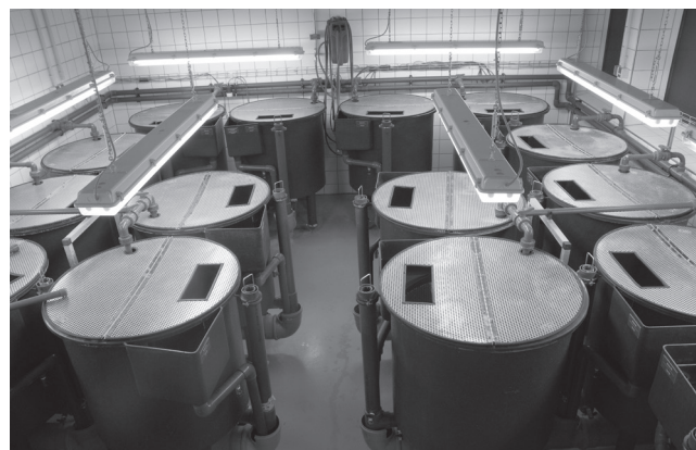
Abbildung 2: Becken der Versuchsanlage der FFS.
