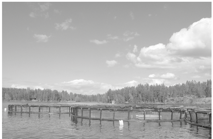
Abbildung 7: Kommerzielle Netzgeheeanlage im Süßwasser.
