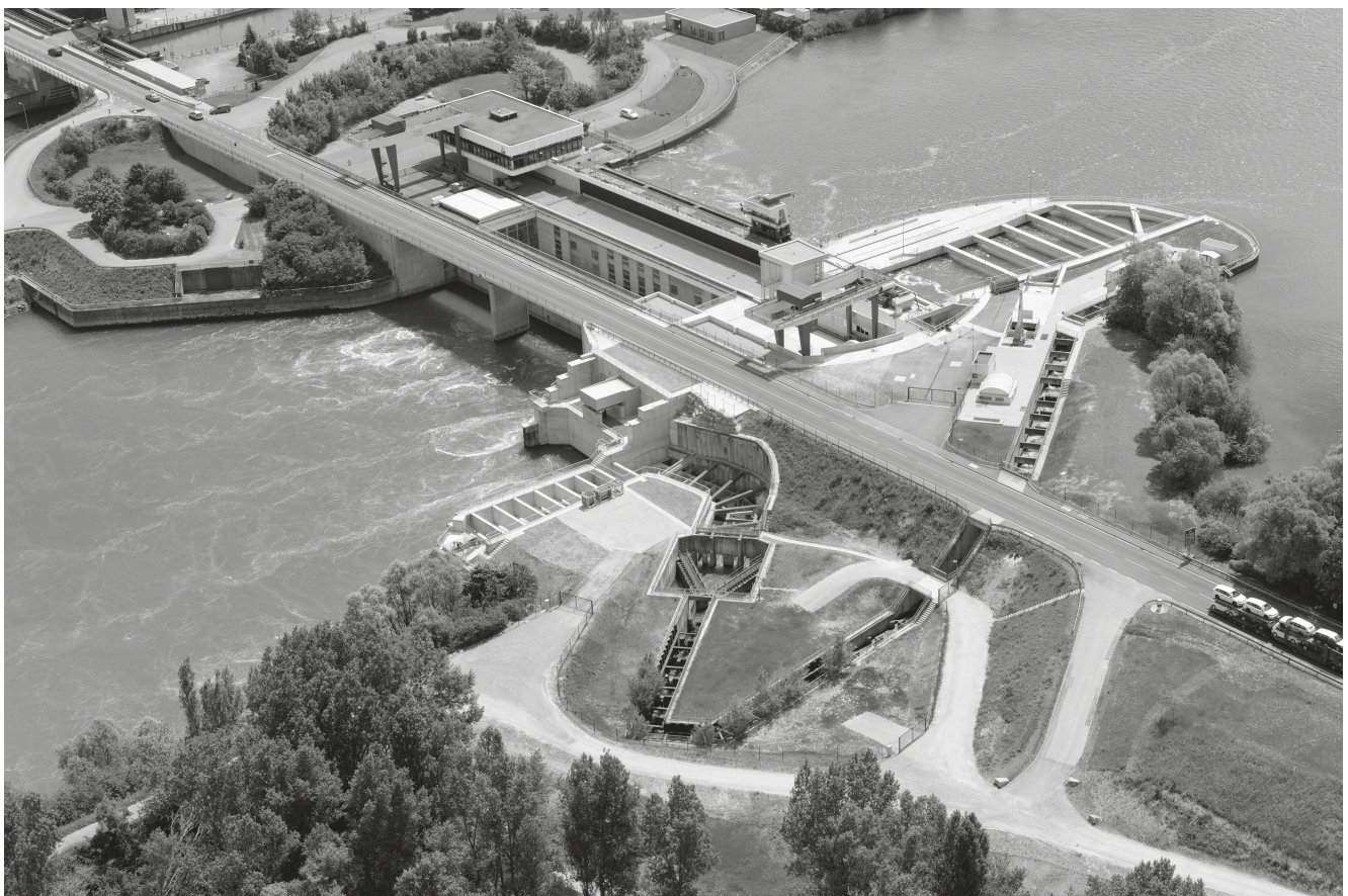
Abbildung 1: Fischpass an der Staustufe Iffezheim nach dem Einbau der Maschine 5 (2014) (Quelle: EnBW).
