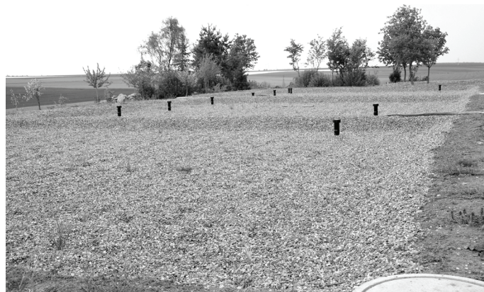
Abbildung 1: Pflanzenkläranlage zum Reinigen des Ablaufwassers.
