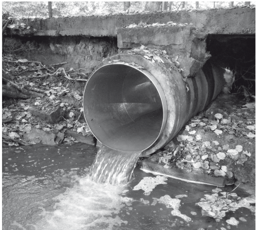
Abbildung 4: Blick in einen der modifizierten Rohrdurchlässe (vom Unterwasser). Die glatte Auskleidung soll die Ausbreitung der Signalkrebse dauerhaft stoppen.
