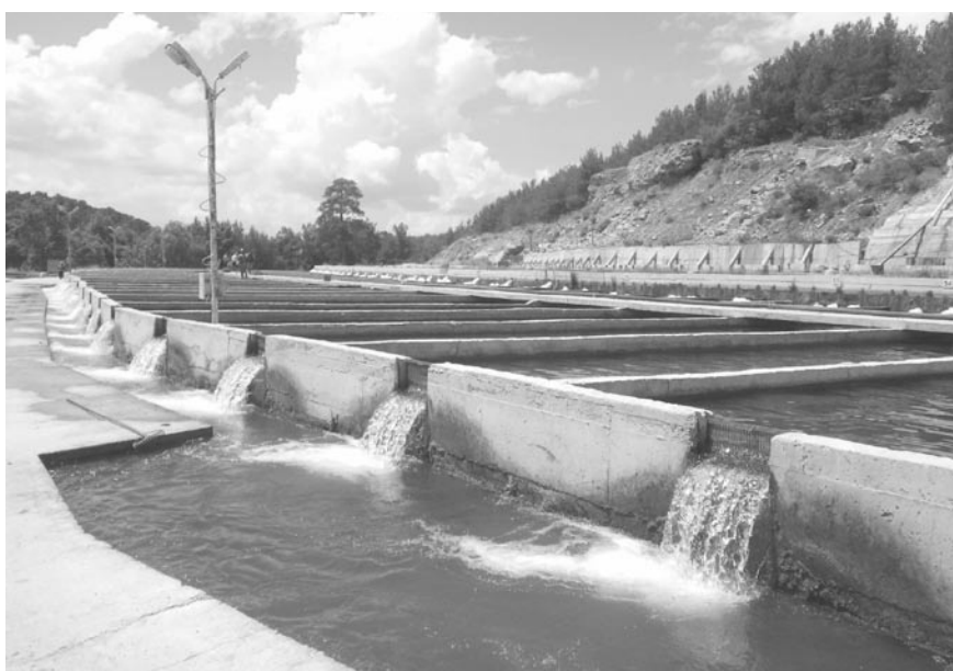
Abbildung 7: Teilansicht der von der Produktionsmenge her größten Anlage, zu beachten ist die pro Rinne durchfließende Menge an Wasser.
