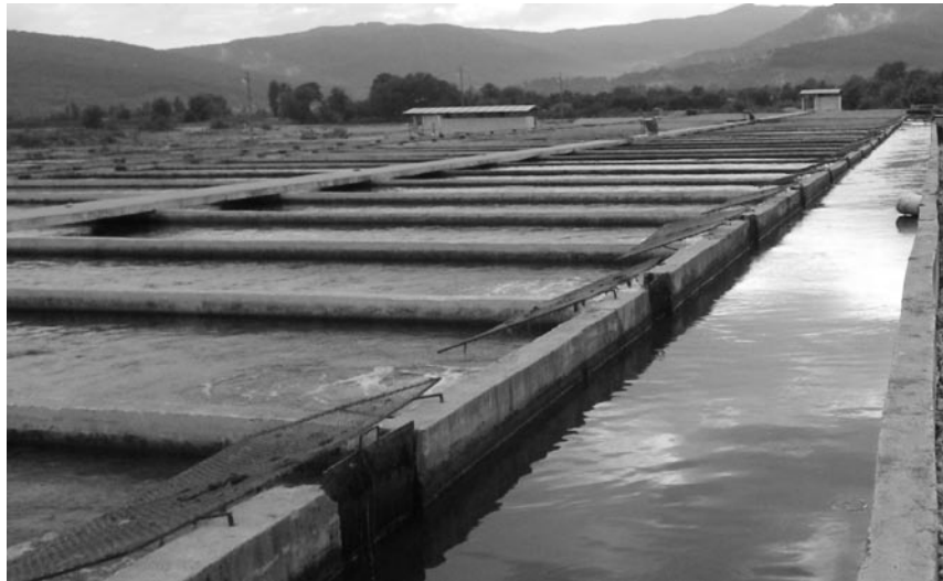
Abbildung 3: Rinnenanlage mit Zulaufkanal.
