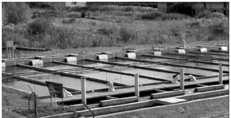
Foto 3: Teilbereich der Anlage 2, am Zulauf jeder Rinne ist ein Eintragskasten (System Grecki) zum Eintrag von reinem Sauerstoff
