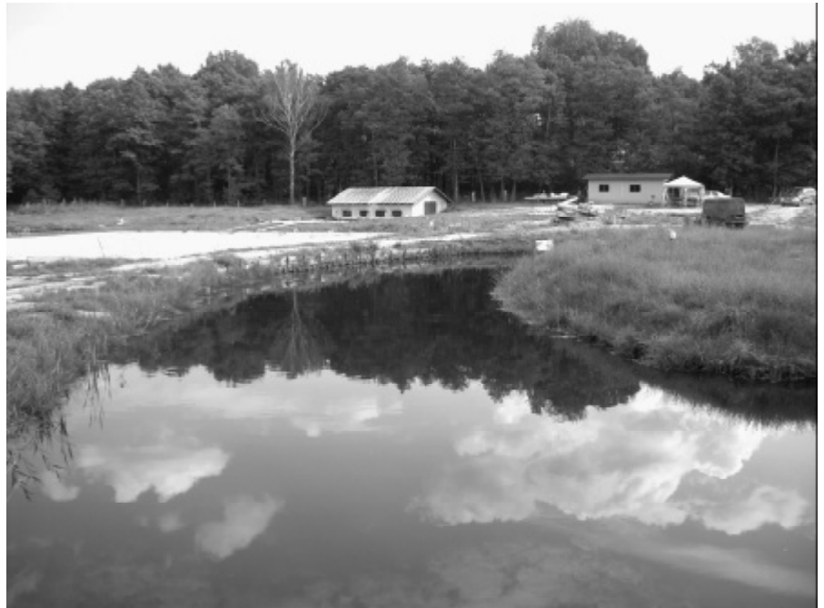
Foto 2: Schönungsteich, durch den das gesamte Wasser der Anlage fließt
