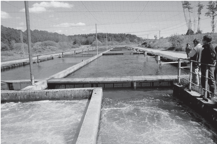
Foto 3: Intensivbelüftung des Wassers am Ende des Fließkanals Foto: Roland Rösch
