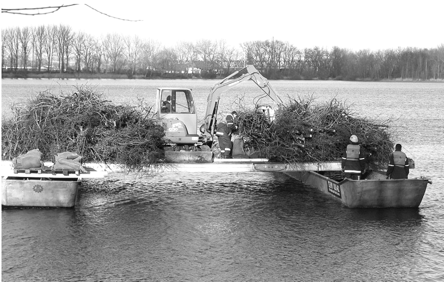
Foto 2: Einbringen von Totholz. Foto: Hartmann
