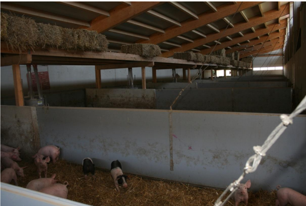
Abb. 3: Die Stroh Bühne über den Buchten sorgt für eine erhebliche Zeitersparnis beim einstreuen, die massiven Betonwände sorgen auch an heißen Sommertemperaturen für eine angenehme Kühle im Maststall der Familie Kainz.
