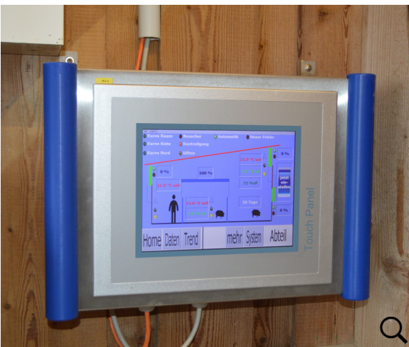
Bild 1: Übersicht über die momentane Lüftungssituation im Stall der alternativen Bauweise an der LSZ Boxberg Foto: LSZ Boxberg
