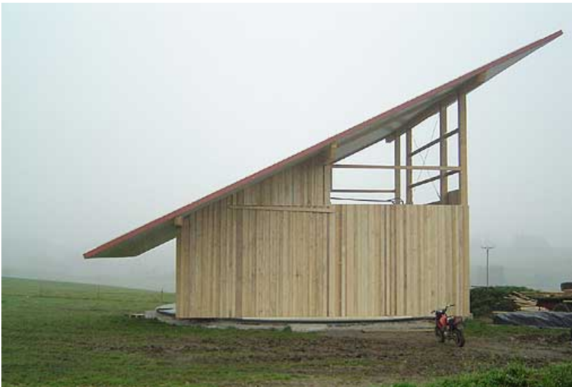
Bild 1: Die drehbar gelagerte Holzhalle „Solarus 1“ der Firma Eggert richtet sich nach dem Lauf der Sonne aus. (Abbildung mit freundlicher Genehmigung der Firma Eggert Stahlbau, Oberstadion)
